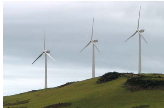
Parque Eólico Isla San Cristóbal- Galápagos
