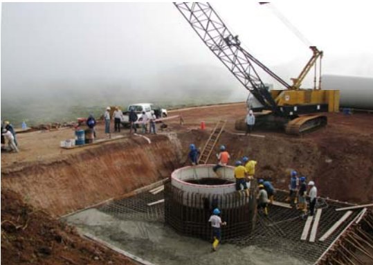
Cimentaciones de aerogeneradores
