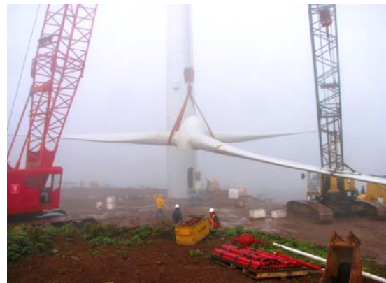
Montaje de las aspas
